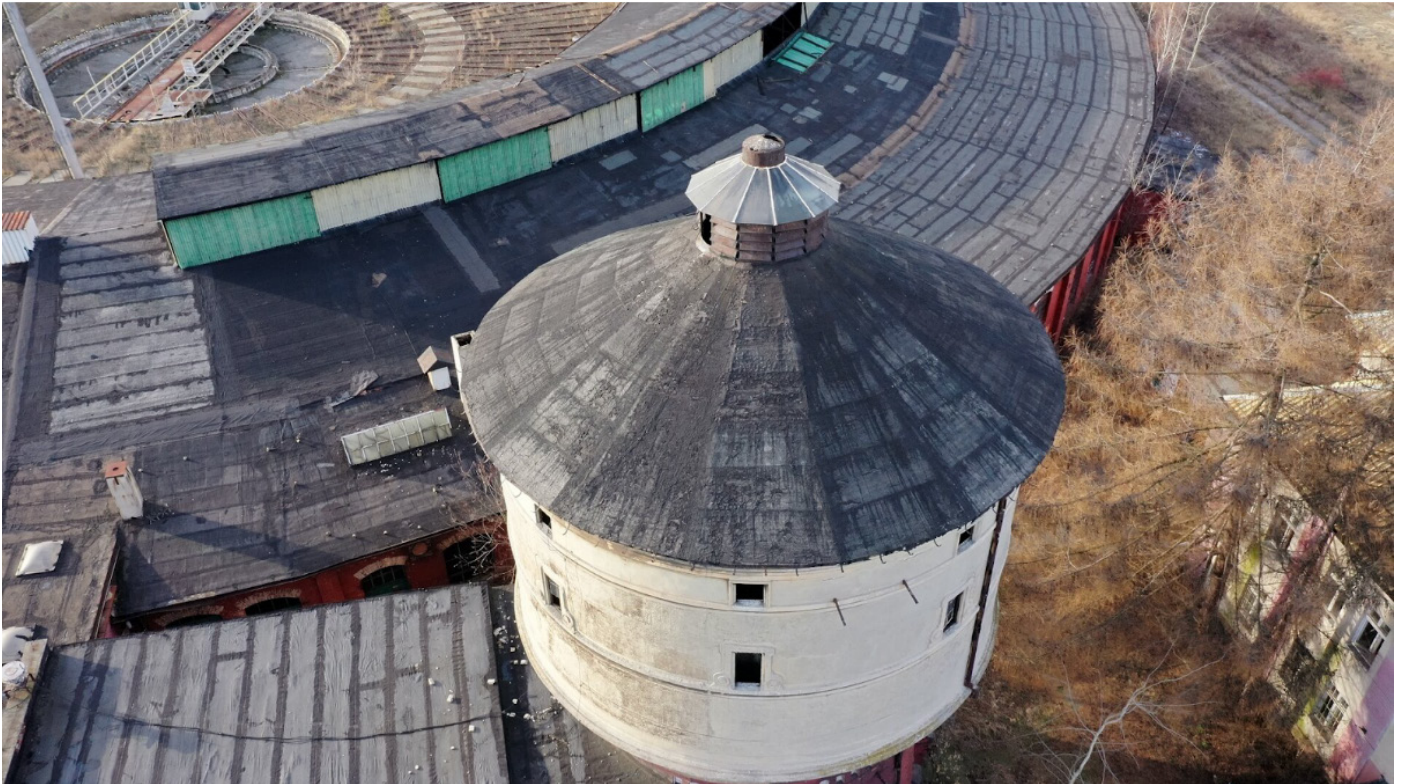
Głowica i dach wieży wodnej. Fot.: Marek Kempa
