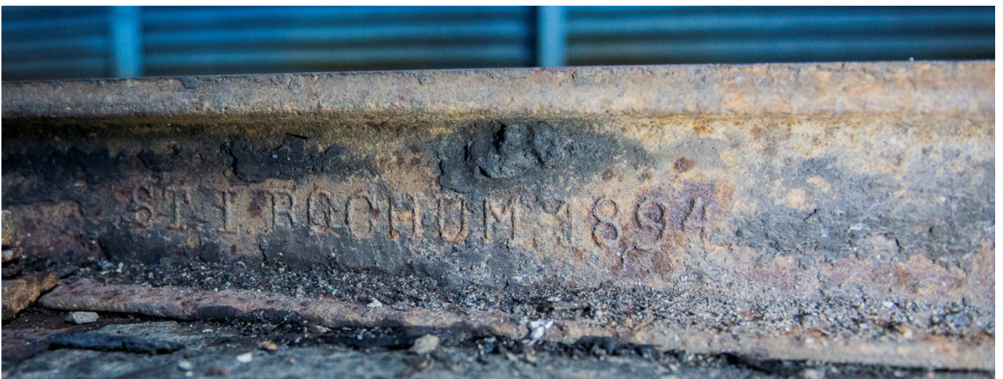
Najstarsza szyna zabudowana na stanowisku nr 1 hali zachodniej. Źródło: Zbiory własne KOZ
