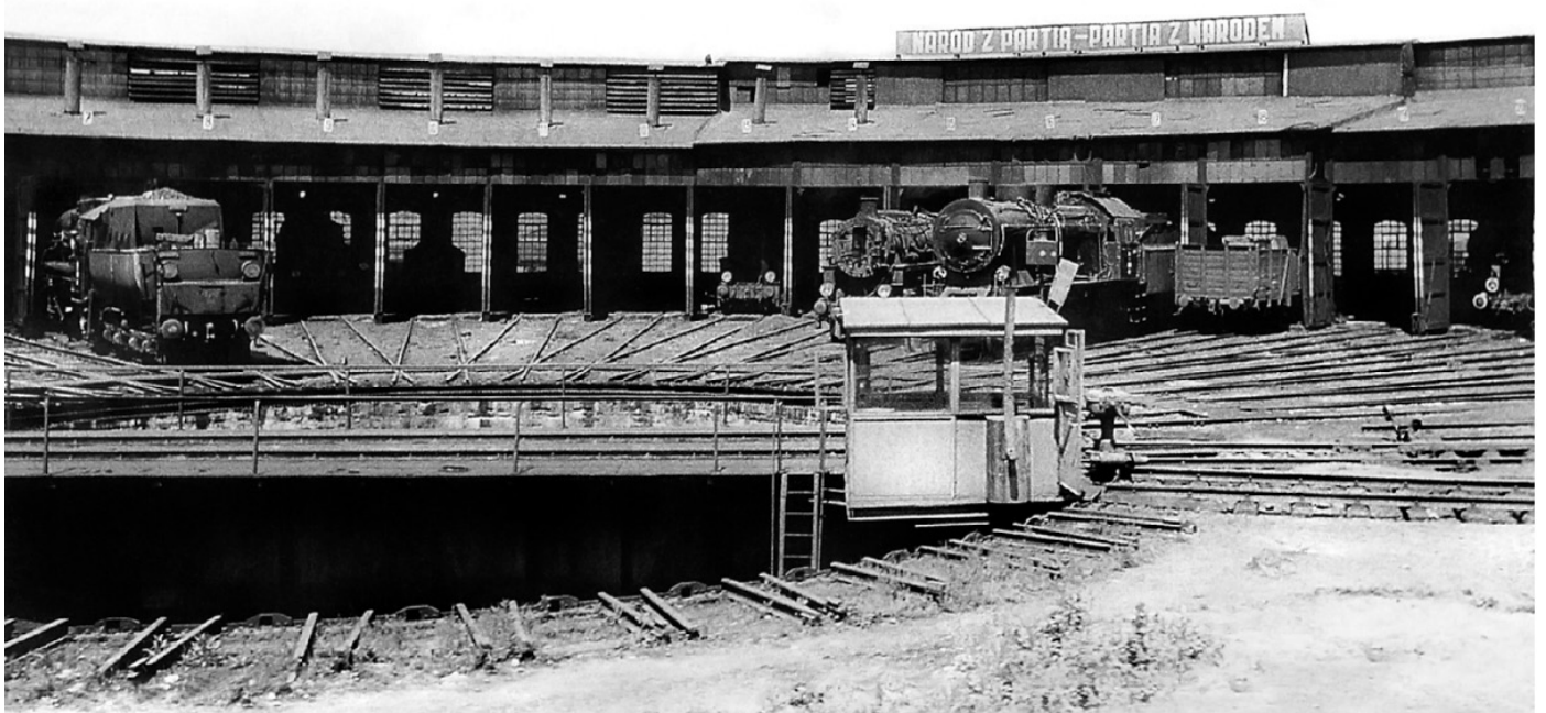
Obrotnica i hala wschodnia w 1962 roku. Źródło: Węzeł Kolejowy Katowice, fot.: H. Griehl
