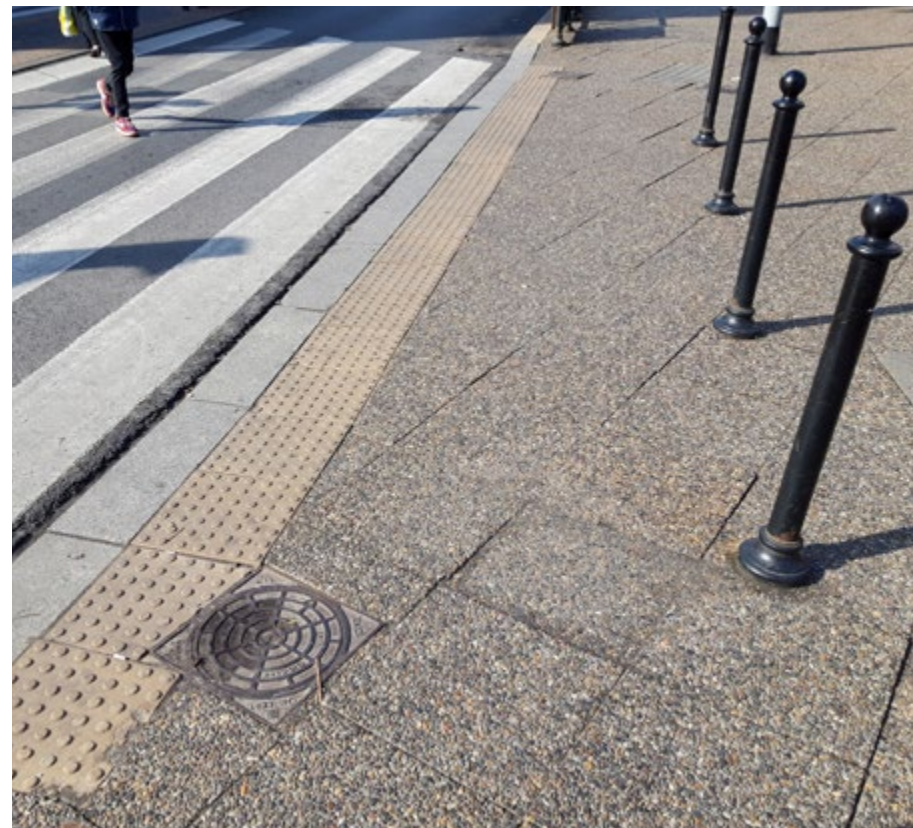
Bytom, przejście dla pieszych z zaznaczonymi kontrastowo polami uwagi, ale też słupkami
