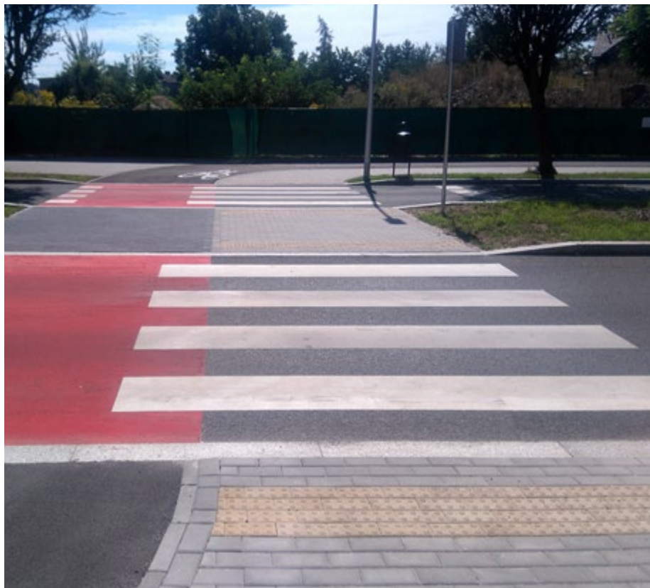
Lubliniec, przejście dla pieszych przy dworcu kolejowym
