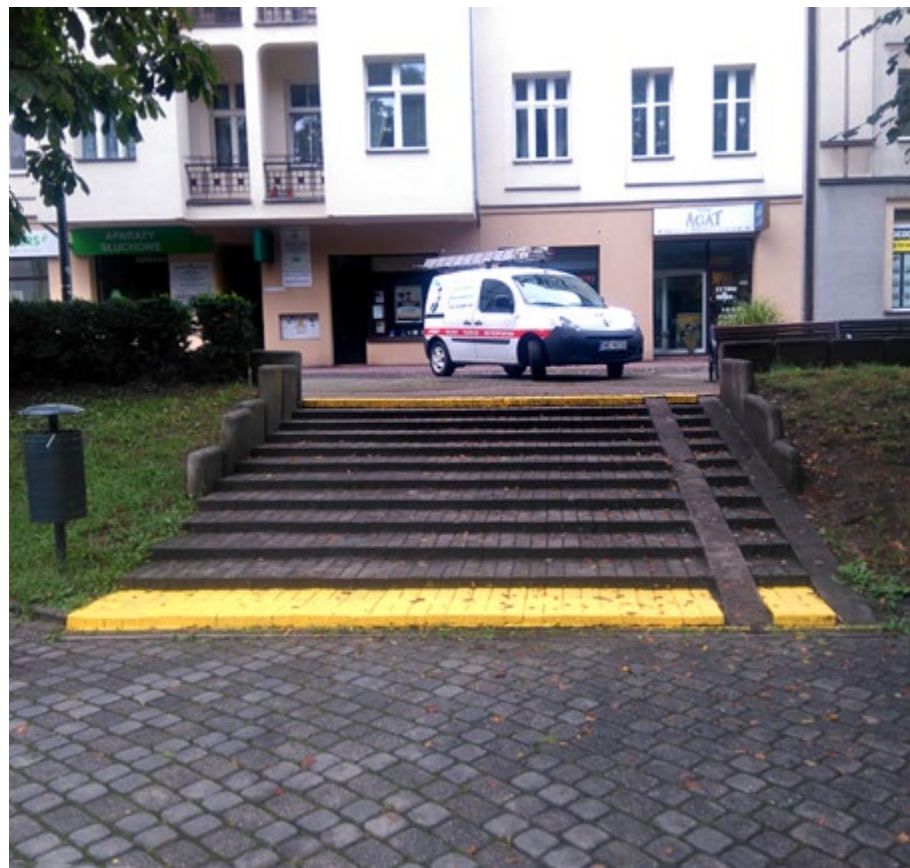
Wodzisław Śląski, Park Zamkowy, kontrastowo oznaczone schody
