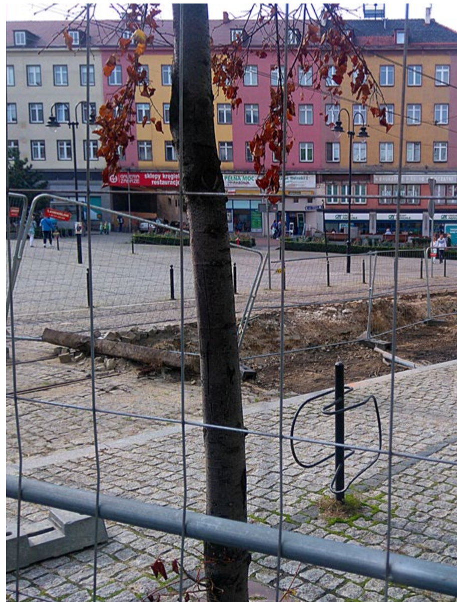
Zabrze, ul. Wolności, remont ogrodzony siatką
