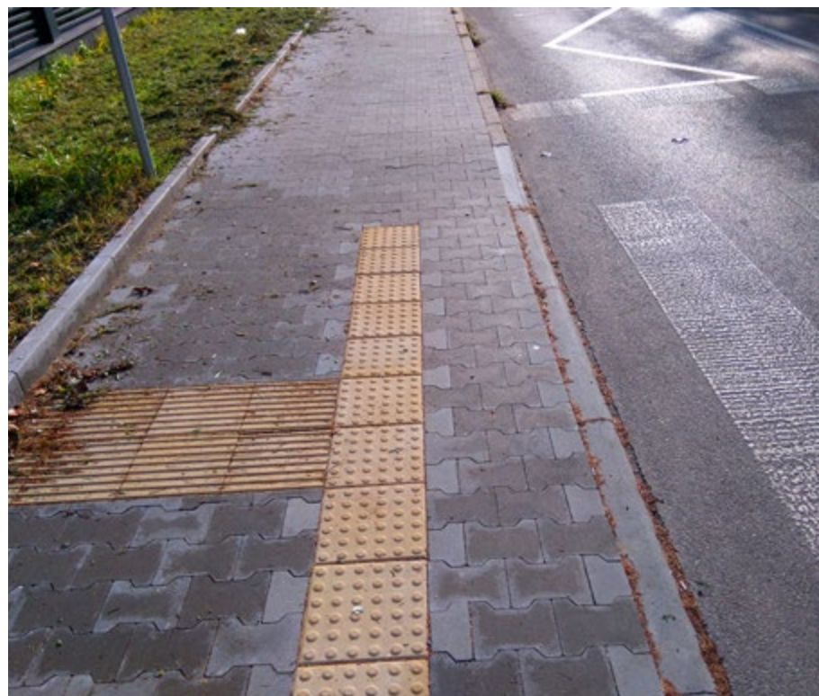
Mikołów, ul. Dzieńdziela, kontrastowe linie wskazujące na przejście dla pieszych
