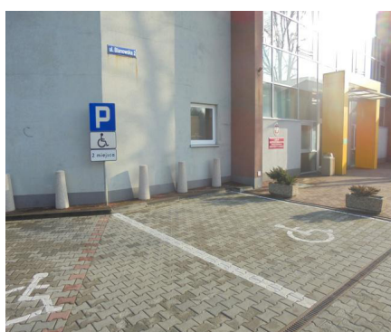
Parking przed budynkiem ZUS miejsca dla niepełnosprawnych
